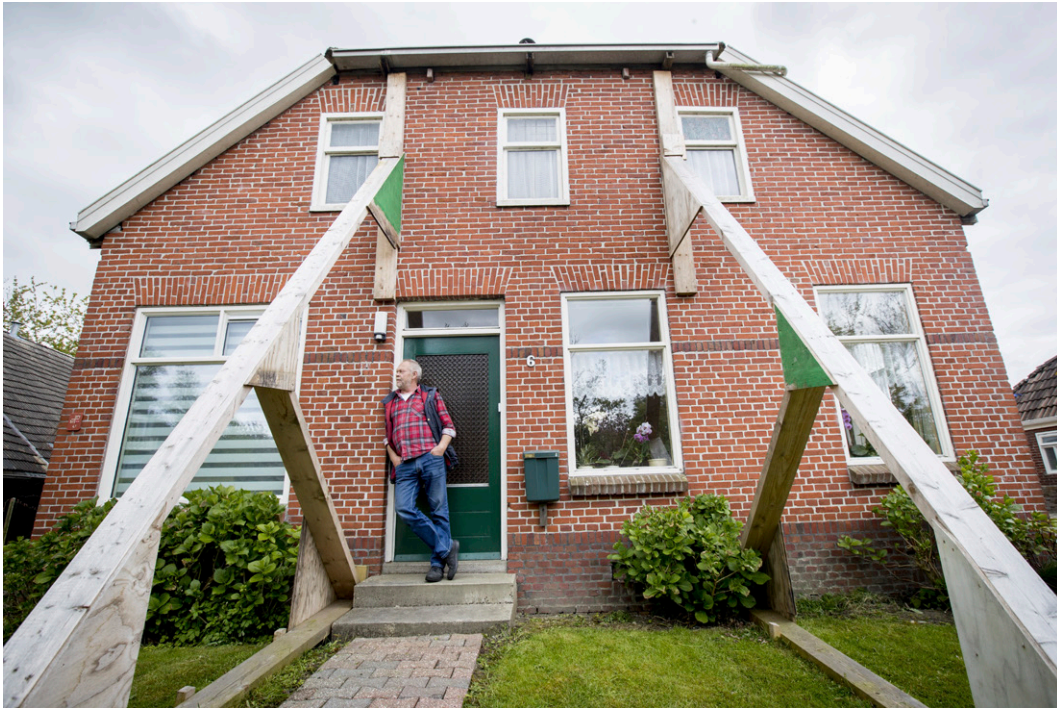
Bewoner voor zijn beschadigde woning. De woning wordt versterkt door stutten in aardbevingsgebied Loppersum. (ANP / Jerry Lampen)
