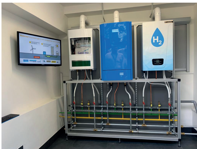
Figuur 31: HR-CV Ketels op waterstof, Rozenburg
